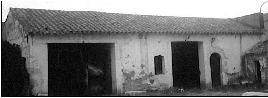
Figura 8. Edificio accessorio 5 castello
