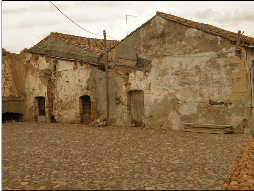
Figura 15. Edificio accessorio 2 castello
