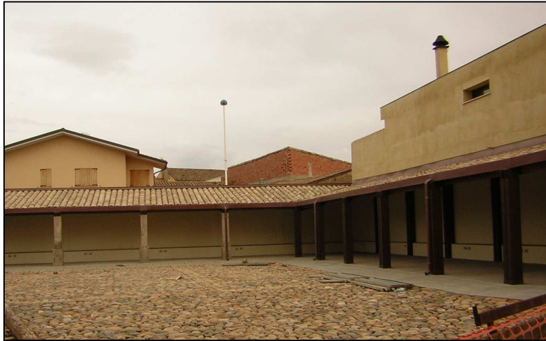
Figura 13. Edificio accessorio 4-5 castello
