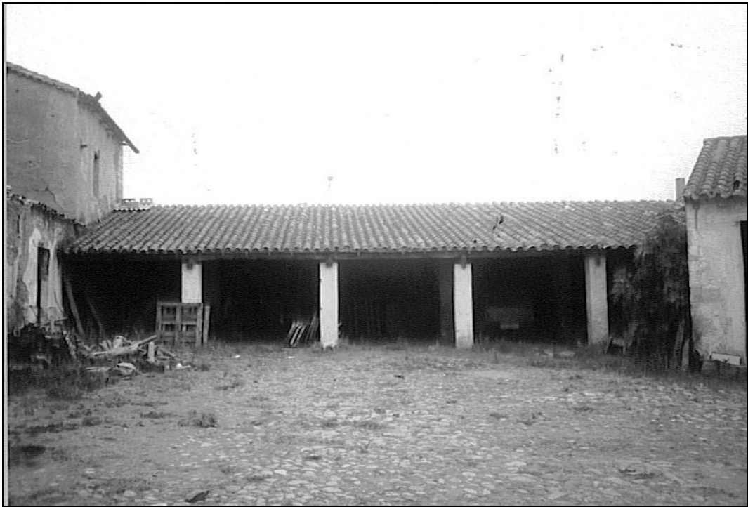
Figura 7. Corpo di fabbrica 4 loggiato
