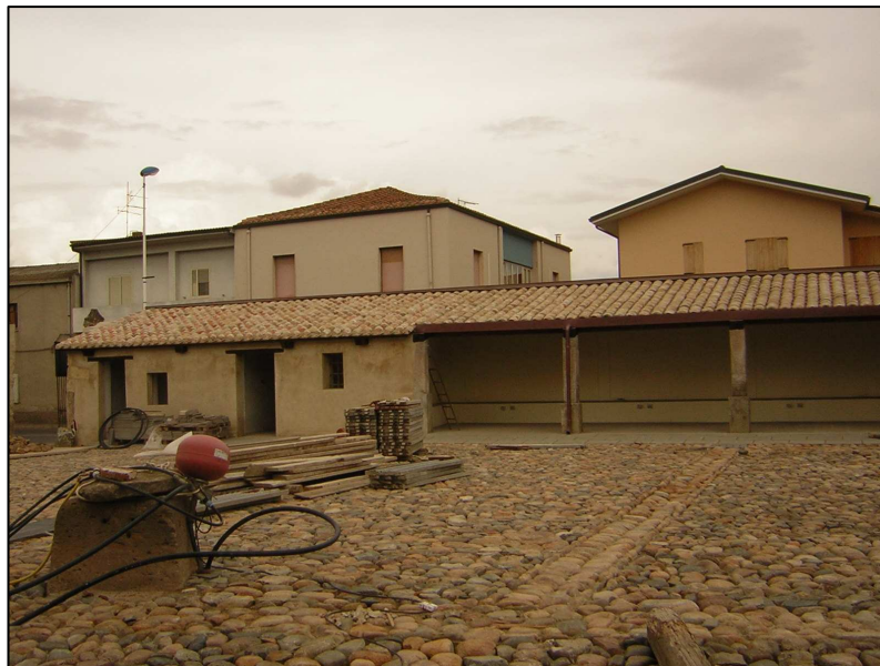
Figura 12. Edificio accessorio 3 castello
